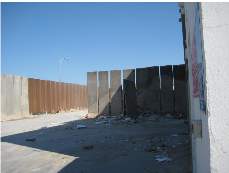
Foto 6 Den nordlige side af lagerhal, tidligere ovnhal og transformere, set mod øst
