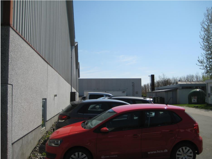
Foto 19 Den vestlige side af lagerbygning, tidligere sølvafdeling med mere, set mod syd
