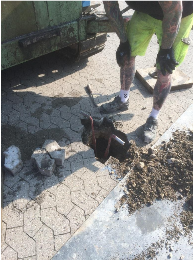
Foto 31 Udførelse af boring 114
