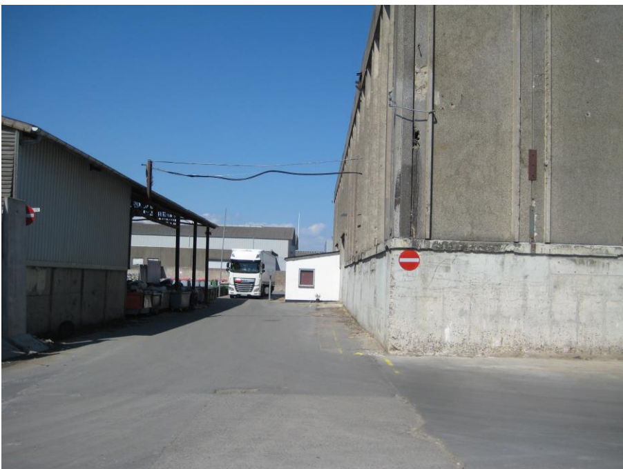
Foto 4 Den vestlige side af lagerhal, tidligere ovnhall og transformer, set mod nord
