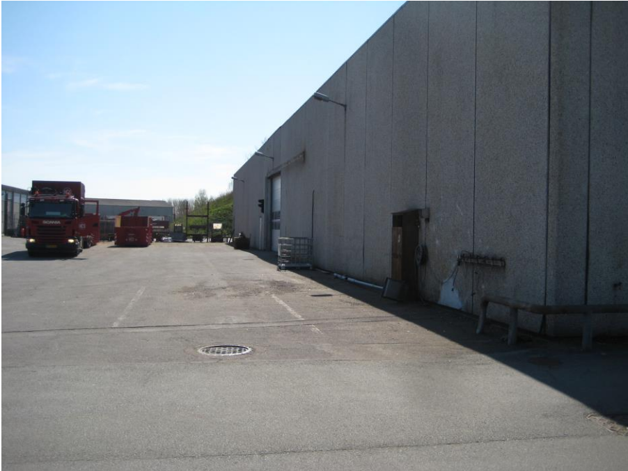
Foto 17 Den østlige side af lagerbygning, set mod syd
