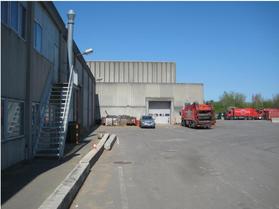
Foto 11 Den østlige side af lagerbygning, set mod nord
