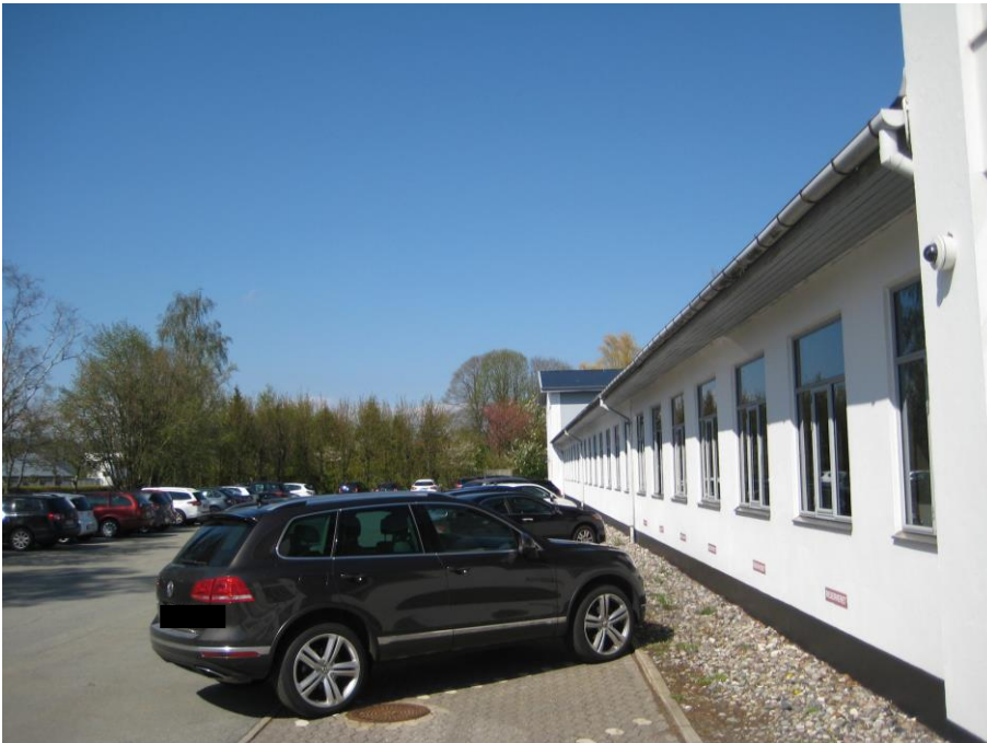
Foto 21 Den vestlige side af administrationsbygninger, set mod nord
