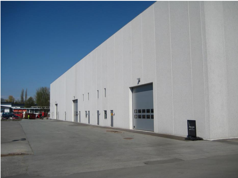
Foto 23 Den vestlige side af lagerbygninger, tidligere ovnhal med mere, set mod nord
