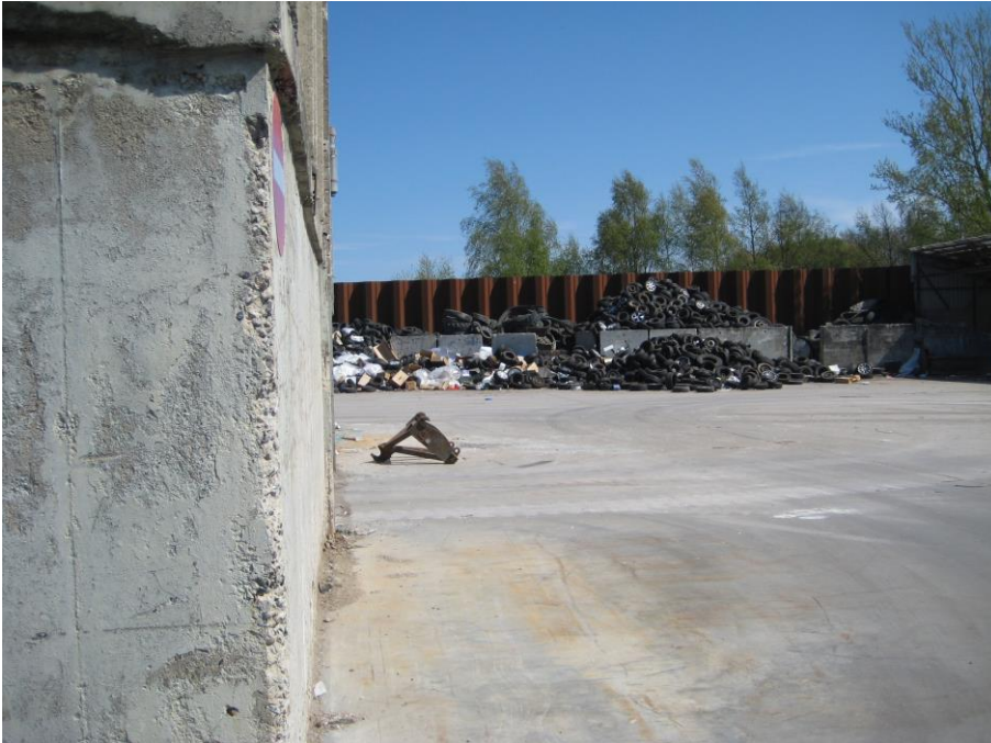
Foto 5 Den sydlige side af lagerhal, tidligere ovnhal og transformere, set mod øst
