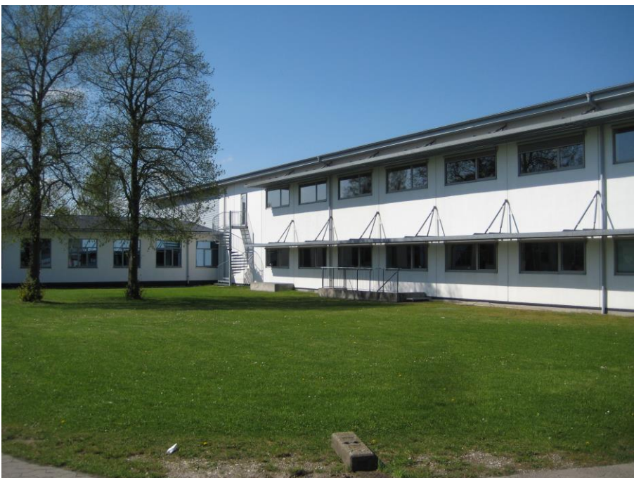
Foto 20 Den sydlige side af administrationsbygninger, set mod nordvest
